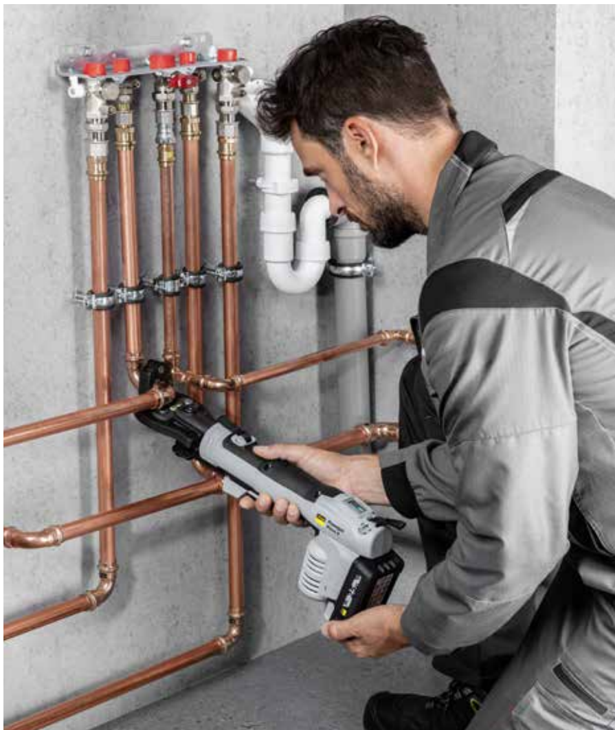
La prise pour mâchoires à sertir rotative à 270° facilite les travaux aux endroits difficiles d'accès.
