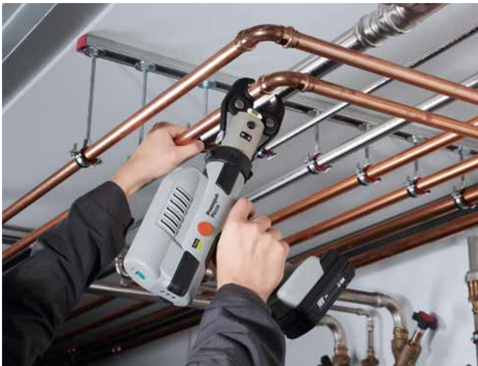
Travaux en hauteur sans problème avec Viega Profipress et la fonction de déclic à une main.
