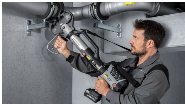
Permet le sertissage de paroi épaisse en acier jusqu'à 4 pouces : le Pressgun-Press Booster.
