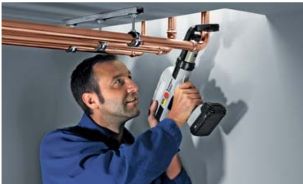
Viega offre des outils de sertissage adaptés aux exigences les plus diverses. La Pressgun Picco par exemple pour les dimensions maximales de 35 mm.
