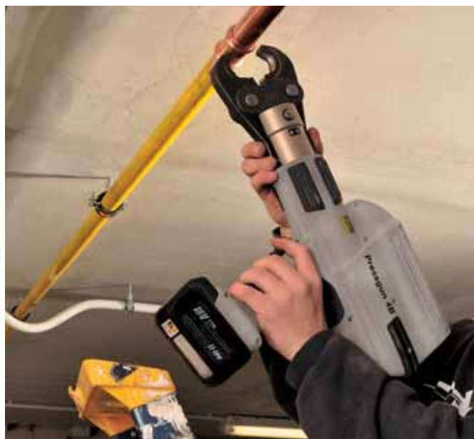
Avec l'outil de sertissage Pressgun, les raccords à sertir Profipress G ont été sertis en toute sécurité pour l'installation gaz du chauffage.
