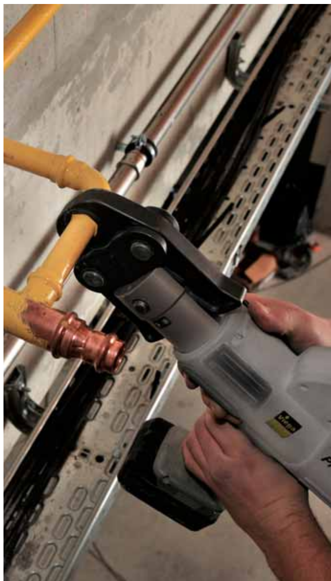
Avec l'outil de sertissage Pressgun, les raccords à sertir Profipress G ont été sertis en toute sécurité pour l'installation gaz du chauffage.
